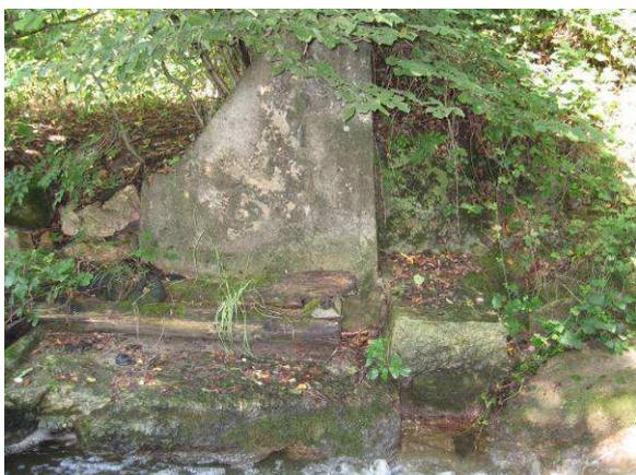
**Restes des infrastructures servant à faire passer le canal sous le ruisseau des Vaux (le mur de béton de forme triangulaire n'est probablement pas d'époque). Le canal passait sur le socle en pierre situé au sol.**
