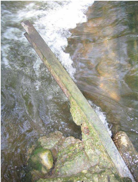
**Pan du barrage affaissé dans l'eau ainsi qu'une poutre d'acier prise dans le béton**
