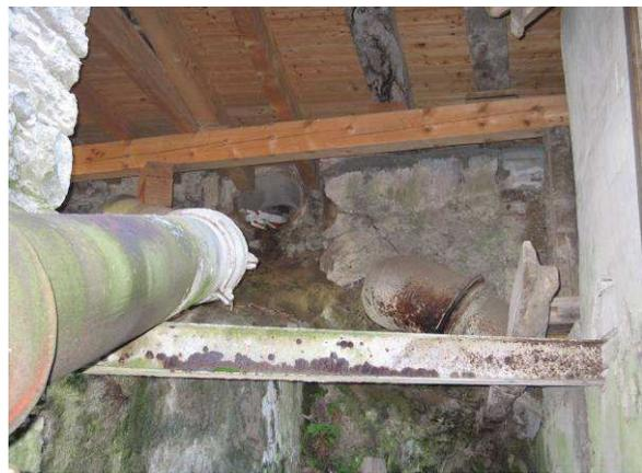
**Cavité où se situaient la roue et les tuyaux qui ont, plus tard, amené l'eau jusqu'à la turbine (bâtiment 53/52)**
