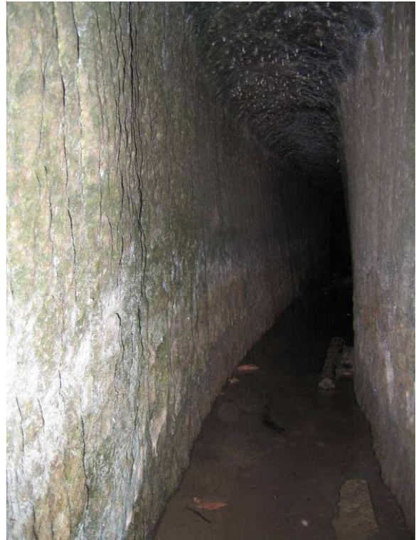
**Tunnel où passait le canal. On peut observer, sur les parois, les traces caractéristiques d'un creusement manuel avec une herminette adaptée au creusement des roches tendres comme la molasse**
